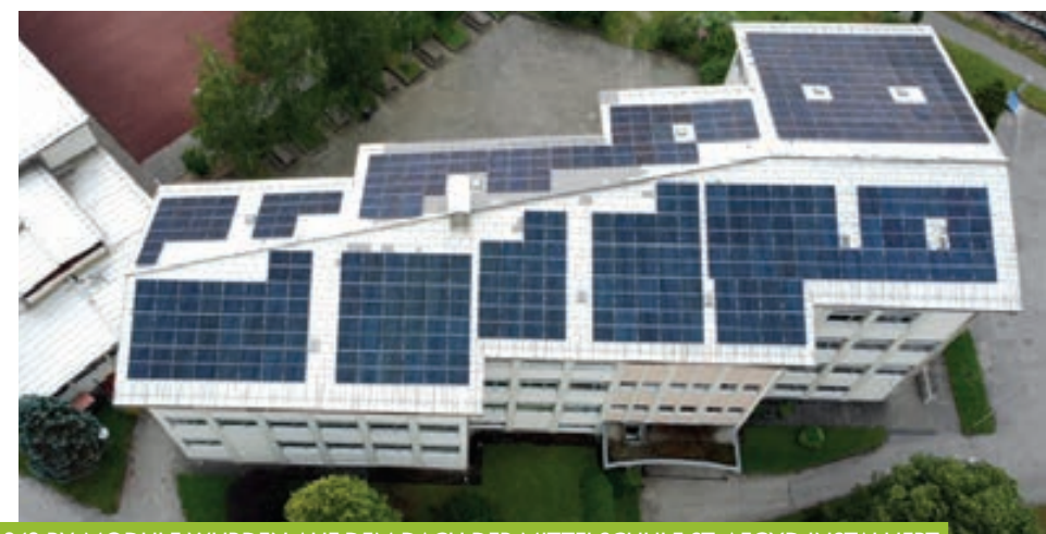
242 PV-MODULE WURDEN AUF DEM DACH DER MITTELSCHULE ST. AEGYDL INSTALLIERT.
